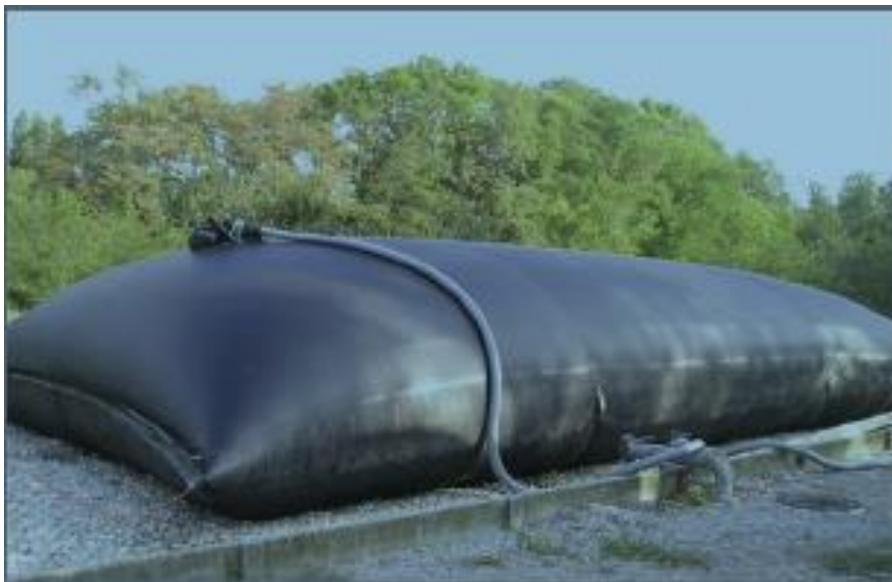
Bild 5.4 Muddermassor pumpas in i en sk. geotub tillsammans med flockningsmedel som binder föroreningarna samtidigt som en passiv avvattning sker.
