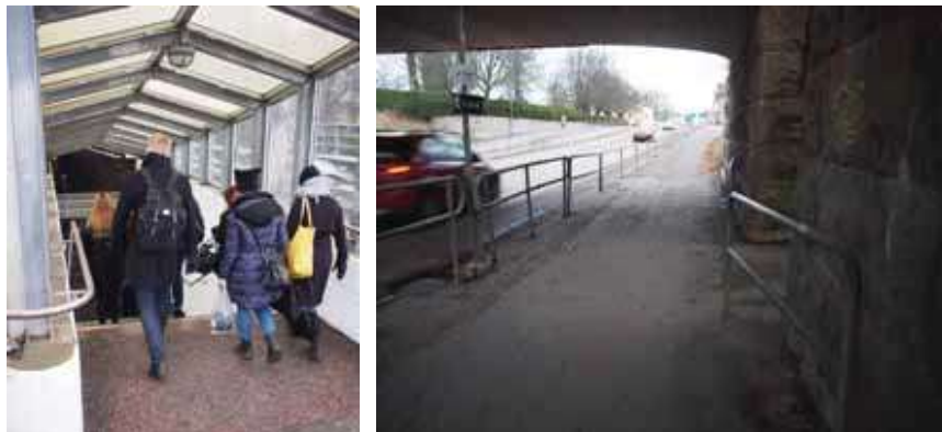
1. Östra nedgången från plattform. En tydlig riktning som leder ner under bron vid Brunnsgatan. Brofästet längs Brunnsgatan har en vacker stenkonstruktion och med vissa ljusinsläpp från taket. Tyvärr är krockrisken mellan fotgängare och cyklister stor, miljön är bullrig och luften känns instängd.
