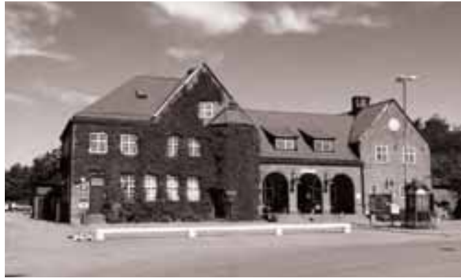
Befintlig stationsbyggnad söder om järnvägen
