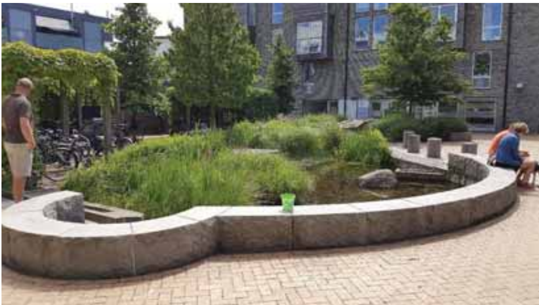
Figur 8-31: Visar ett exempel av en växtbädd, där vattnet samlas för att sedan rinna vidare ut i område med multifunktionell yta. Foto: Structor
