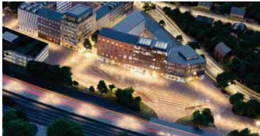
Soltrappan blir en viktig och rörelseintensiv entréplats till Nöthagen som kopplar området till Nyköpings Resecentrum och Nyköping.
