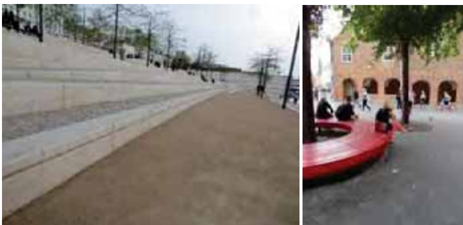
Soltrappan blir en viktig mötespunkt mellan Nöthagen och Nyköping resecentrum, samt centrala Nyköping
