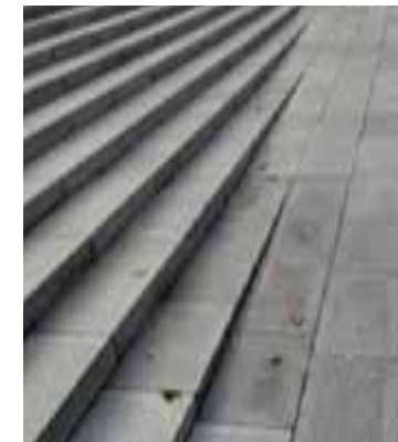
Bred trappa som går in i ramp
