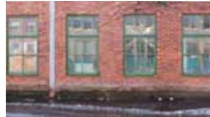
Maskinhallens spröjsade fönster bevaras.
