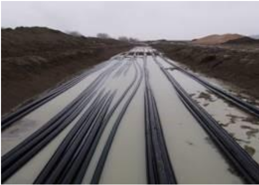
Figur 21. Exempel på 130 kV kabelschakt med sex förband.
