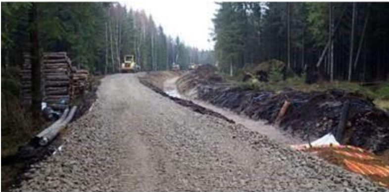
Figur 22. Exempel på arbetsväg parallellt med 130 kV kabelschakt för ett till två förband.
