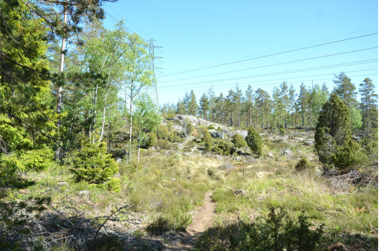
Figur 45. I bilden illustreras ett fotomontage på hur de nya ledningarna kan komma att se ut norr om Näsön. Ledningssträckningen viker här av österut och löper parallellt med befintlig ledningsgata mot Oxelösund. Stigen i förgrunden är Sörmlandsleden.
