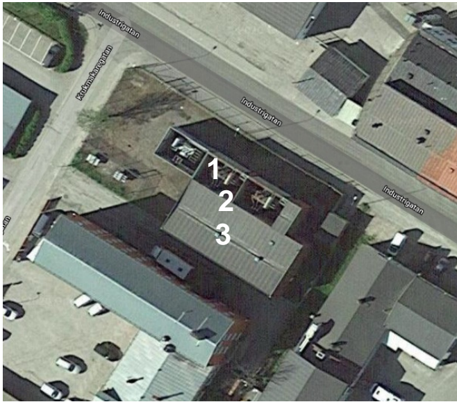
Figur 14. Ungefärliga mätpositioner på bild från Google Maps. Position 1 är belägen nere på marknivå, intill transformator nr 2. Mätposition 2 är på taket, precis vid kanten, 1 meter ovanför taket. Position 3 är ungefär mitt på tak, 1 meter ovan tak.
