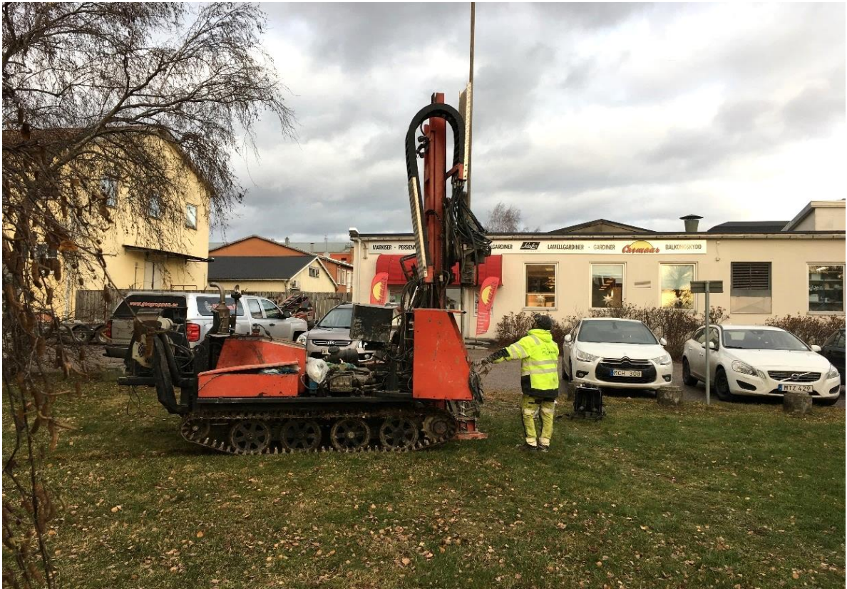
Figur 6. Bild tagen mot norr vid provpunkten BP11.
