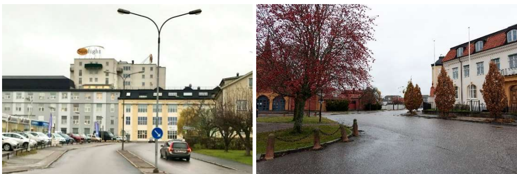
Foto 1-2. Sunlightfabrikens fasader mot Industrigatan och Nytorget med huvudentré till Sunlight och bebyggelse från tidigt 1900-tal. (Urban Minds 2019).
