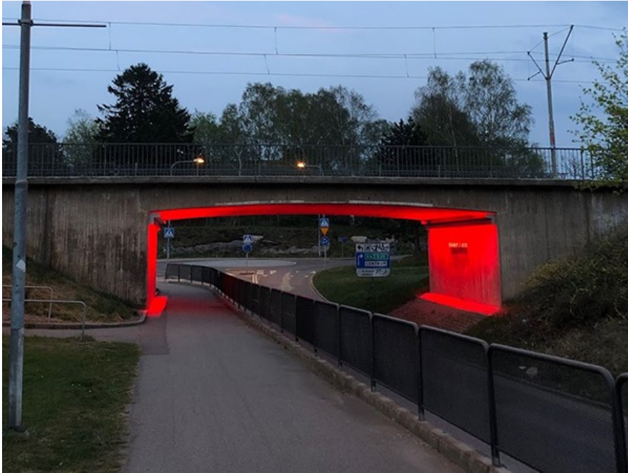
Tunneln på Regementsvägen i Kviberg konstnär Ola Åstrand, blodet i oss, 2019. Foto: Lars Ocklund
