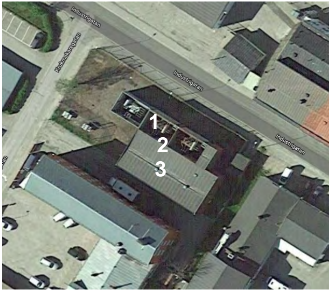
Figur 14. Ungefärliga mätpositioner på bild från Google Maps. Position 1 är belägen nere på marknivå, intill transformator nr 2. Mätposition 2 är på taket, precis vid kanten, 1 meter ovanför taket. Position 3 är ungefär mitt på tak, 1 meter ovan tak.
