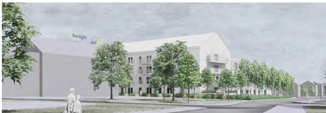
Figur 15: Det särskilda boendets hisspaket skymtar ovan befintlig byggnads sadeltak till vänster men har en begränsad påverkan på siktlinjen i vy från Hemgårdsvägen (Arkitema, 2021).
