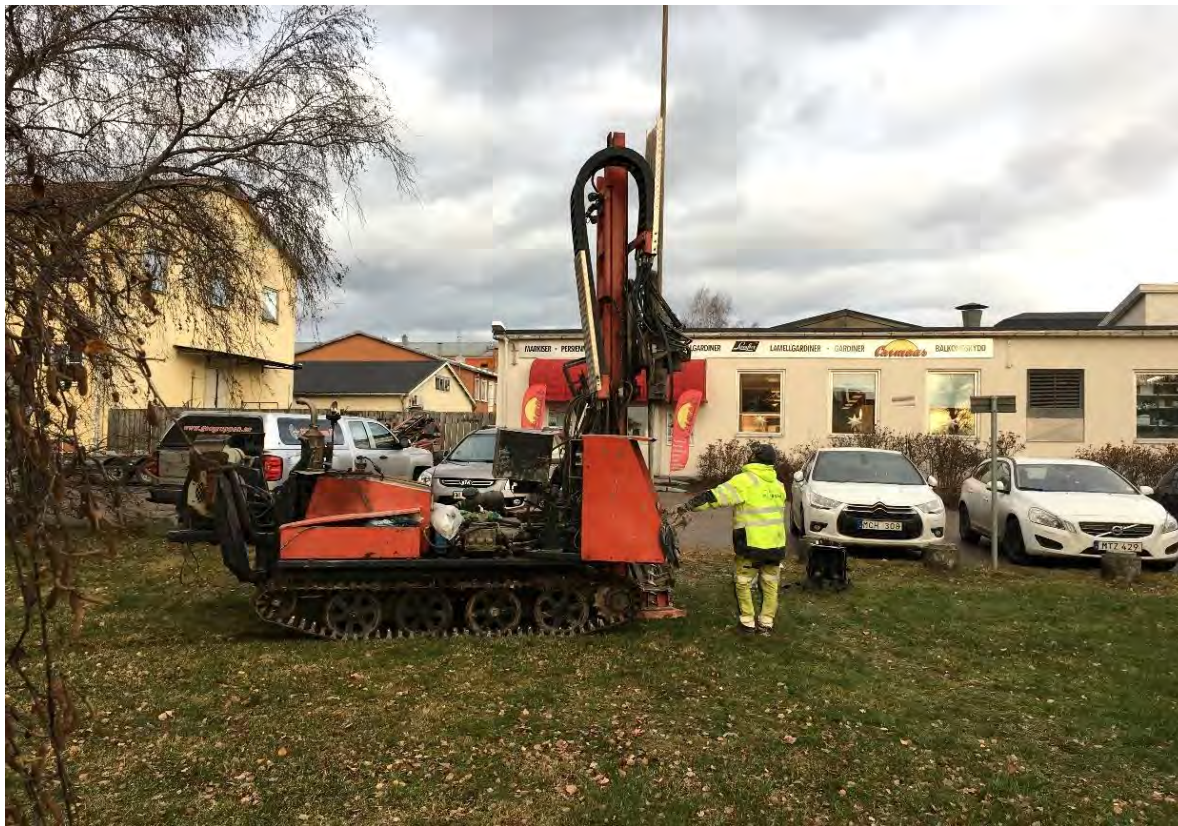
Figur 6. Bild tagen mot norr vid provpunkten BP11.
