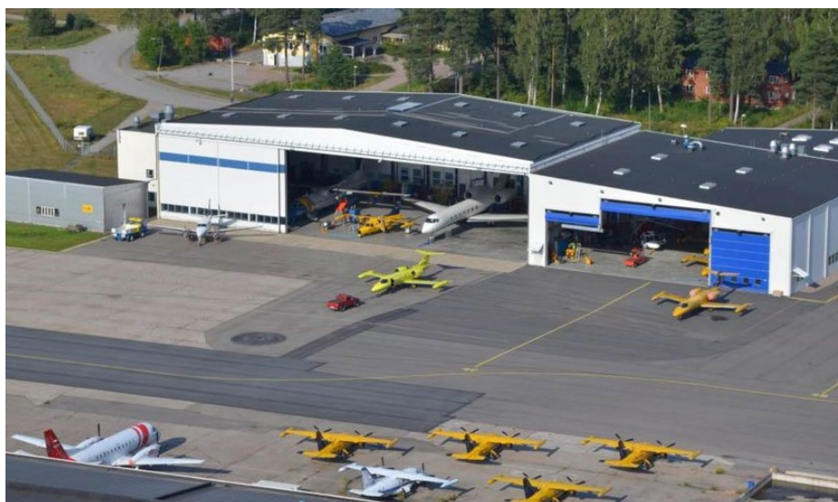
Foto 1. Hangaren på fastigheten Skavsta 8:10, SAAB och Kustbevakningen är hyresgäster.
