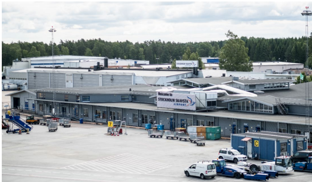
Foto 2. Terminalbyggnaden, norra fasaden.
